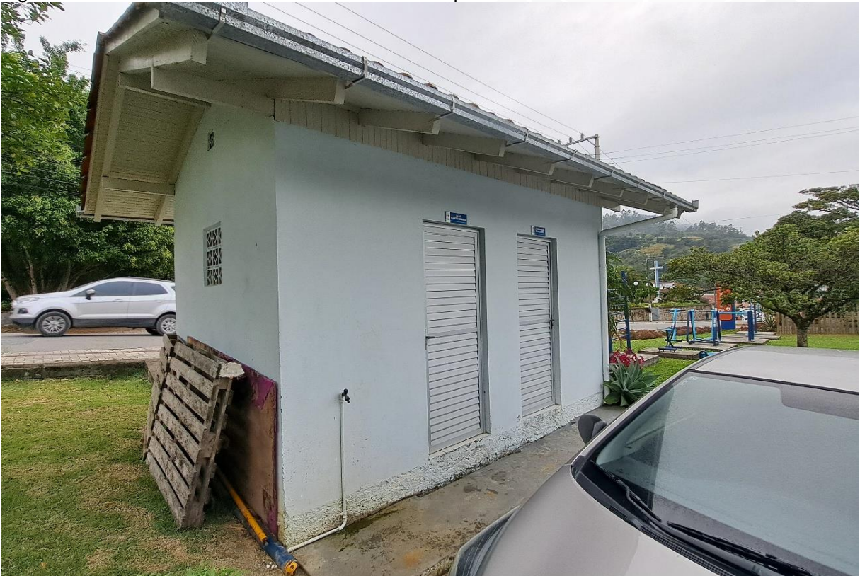
Figura 14: Armazenamento externo de resíduos - Hospital – em 04/04/2024.
