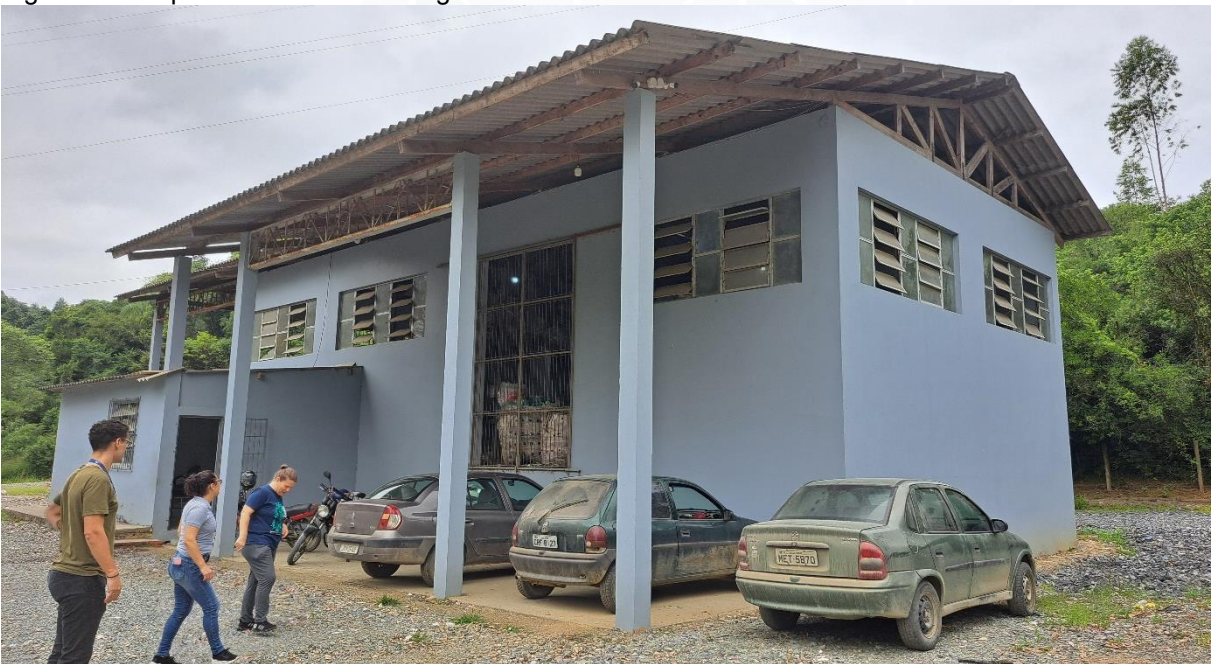
Figura 11: Galpão da unidade de triagem – em 04/04/2024.
