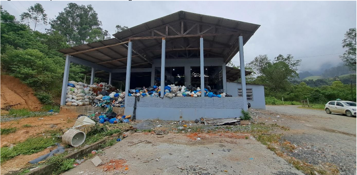
Figura 10: Galpão da unidade de triagem - Área de recebimento dos resíduos – em 04/04/2024.
