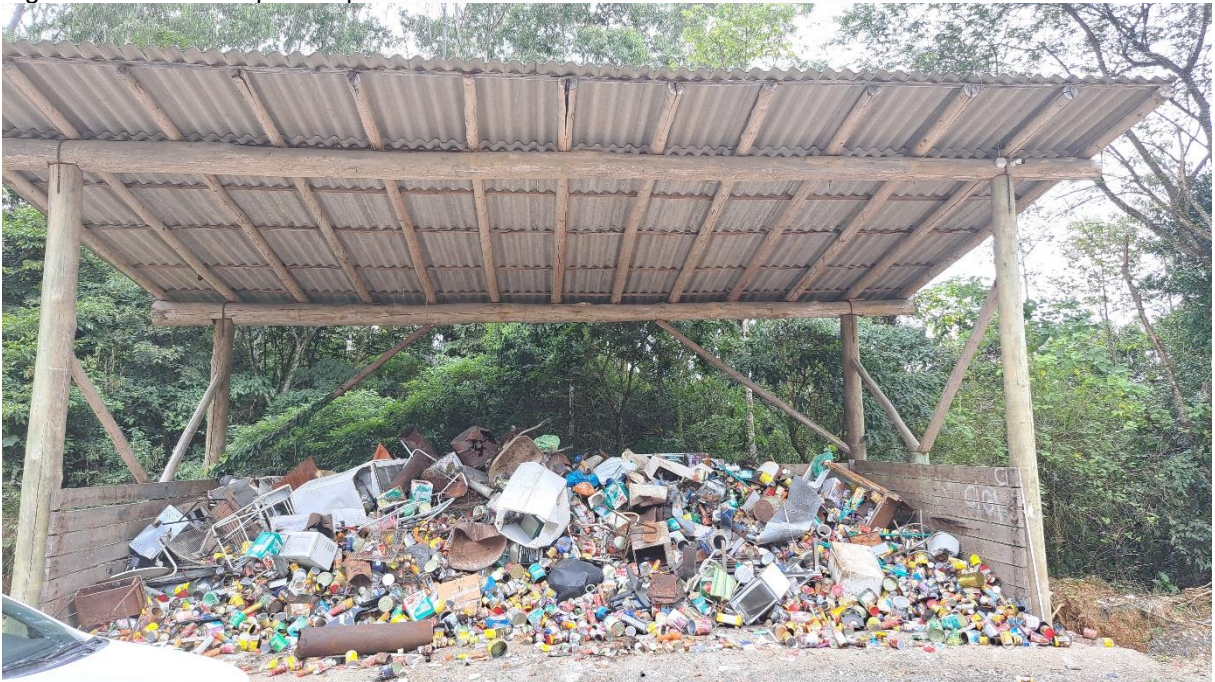
Figura 13: Cobertura para depósito de resíduos metálicos – em 04/04/2024.
